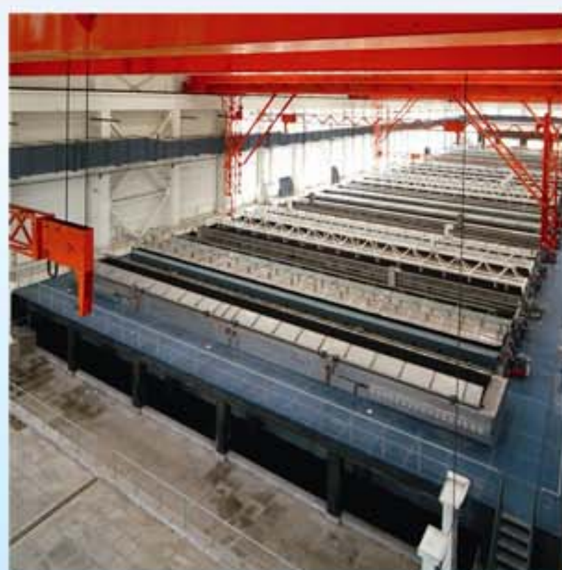
项目名称：大型阳极化生产线
