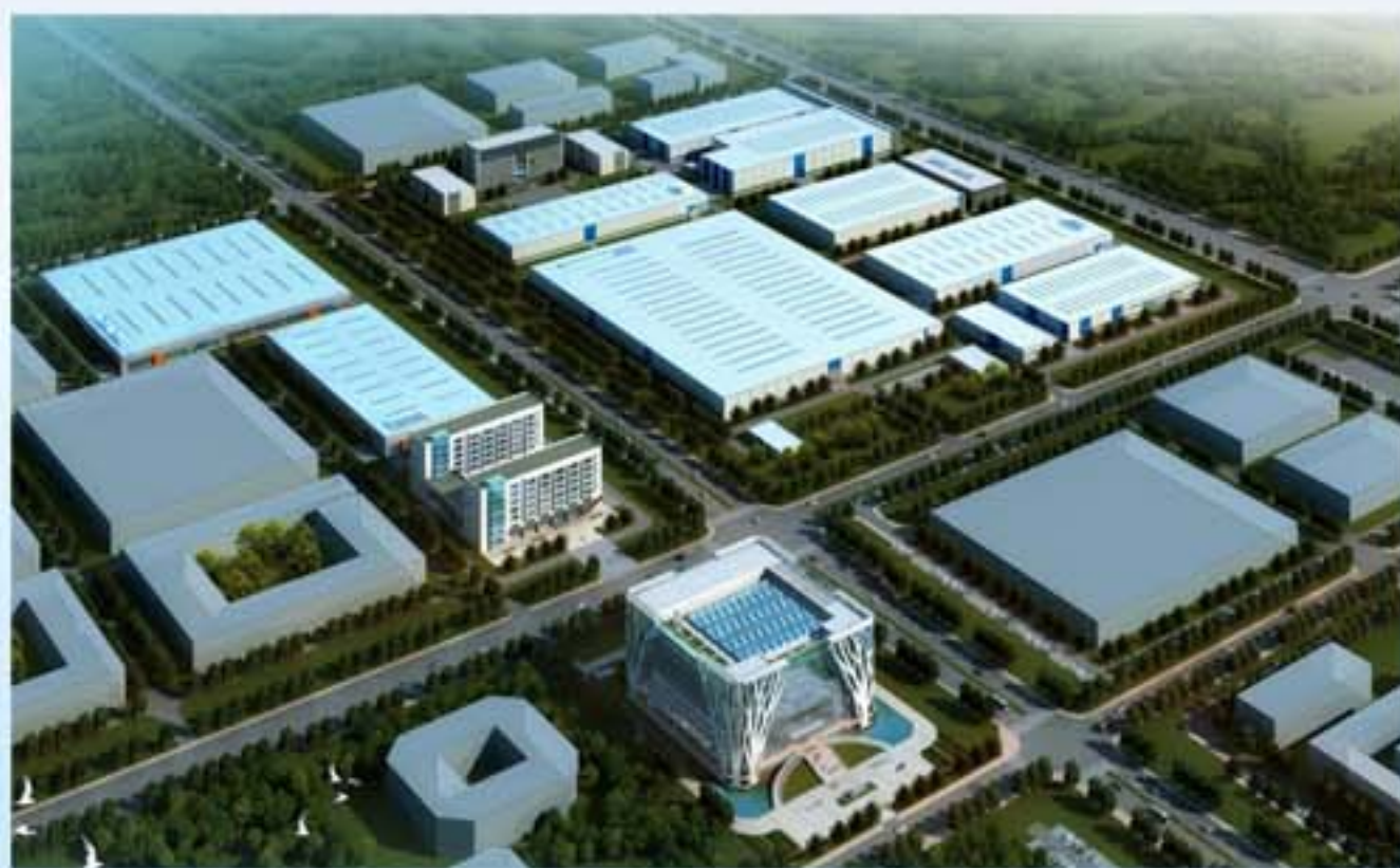
项目名称：复合材料生产线 建筑面积：18000m 特点：该厂房通过了波音、空客、AIRBUS及NADCAP等相关认证，车间按照FACC体系管控
